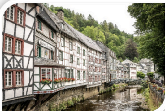
Les maisons à colombage
